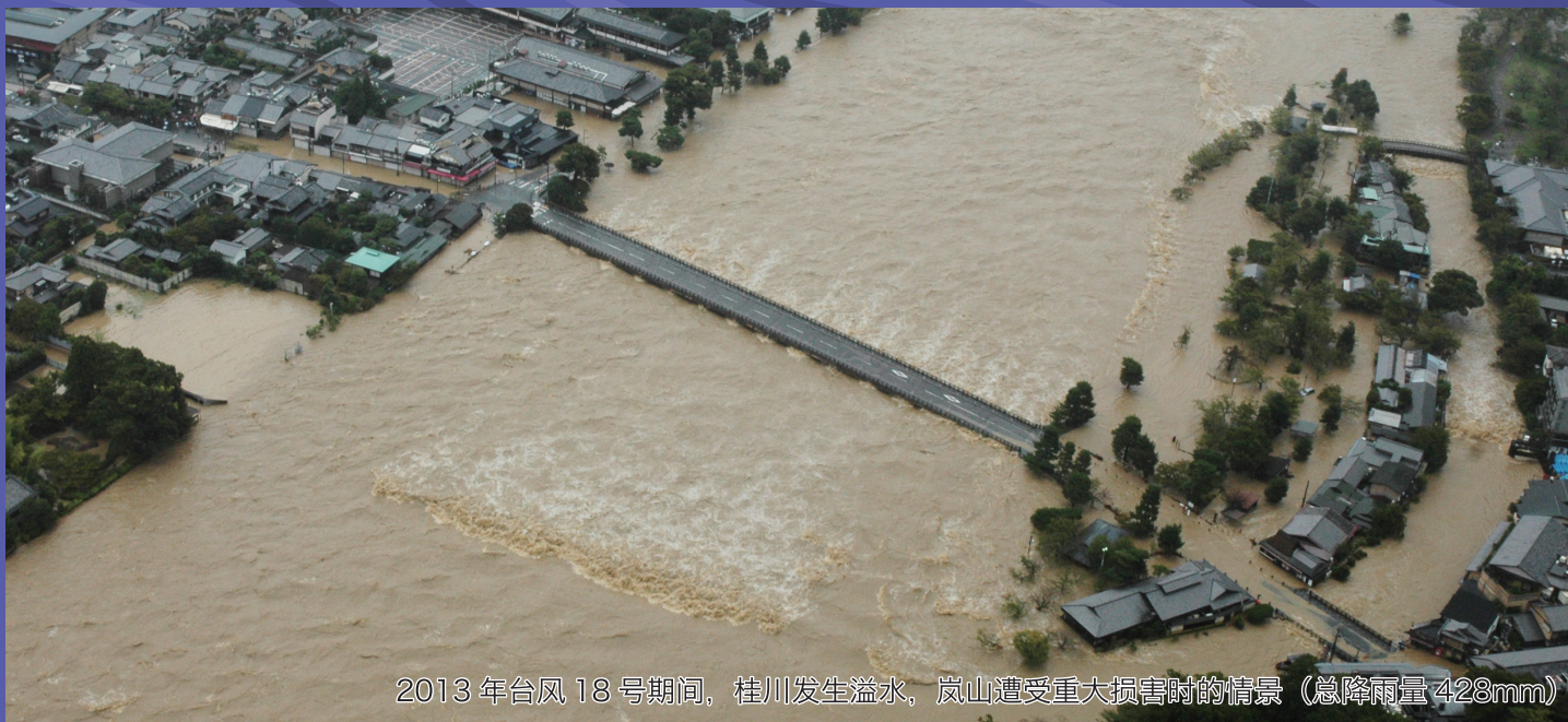
2013 年台风 18 号期间，桂川发生溢水，京山遭受电力销售时的情景（总降水量 228mm）
